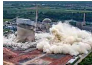
Die Kühltürme des KKW Philippsburg wurden im Mai 2020 gesprengt
